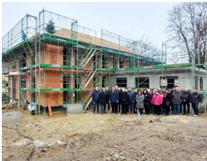
Pfarrer Michael Schwertfirm, Bürgermeister Michael Franken (JWU) sowie zahlreiche Ehrenamtliche der Pfarrei freuten sich gemeinsam über den Baufortschritt beim neuen Pfarrhaus mit Pfarrsaal, direkt neben dem Rathaus in Reichertshofen. Foto: Verena Vogl
