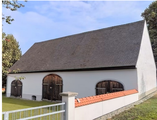
Kirchplatz 8 Scheune; D-1-86-144-5 zweigeschossiger, traufseitiger Satteldachbau mit Bändergliederung, 1834, nach Brand 1837-1839 wiederaufgebaut; Pfarrstadel, traufseitiger, verputzter Massivbau mit Steilsatteldach und drei korbbogigen Toren, 18./19. Jh.; ehem. Stallgebäude, jetzt Pfarrheim, Erdgeschossiger, traufseitiger Satteldachbau, wohl 1834.
