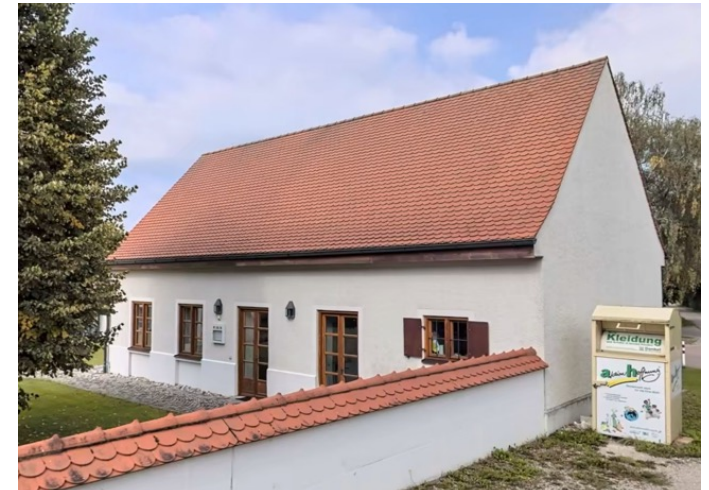
Kirchplatz 8 (Pfarrheim) ehem. Stall; D-1-86-144-5 zweigeschossiger, traufseitiger Satteldachbau mit Bändergliederung, 1834, nach Brand 1837-1839 wiederaufgebaut; Pfarrstadel, traufseitiger, verputzter Massivbau mit Steilsatteldach und drei korbbogigen Toren, 18./19. Jh.; ehem. Stallgebäude, jetzt Pfarrheim, Erdgeschossiger, traufseitiger Satteldachbau, wohl 1834.
