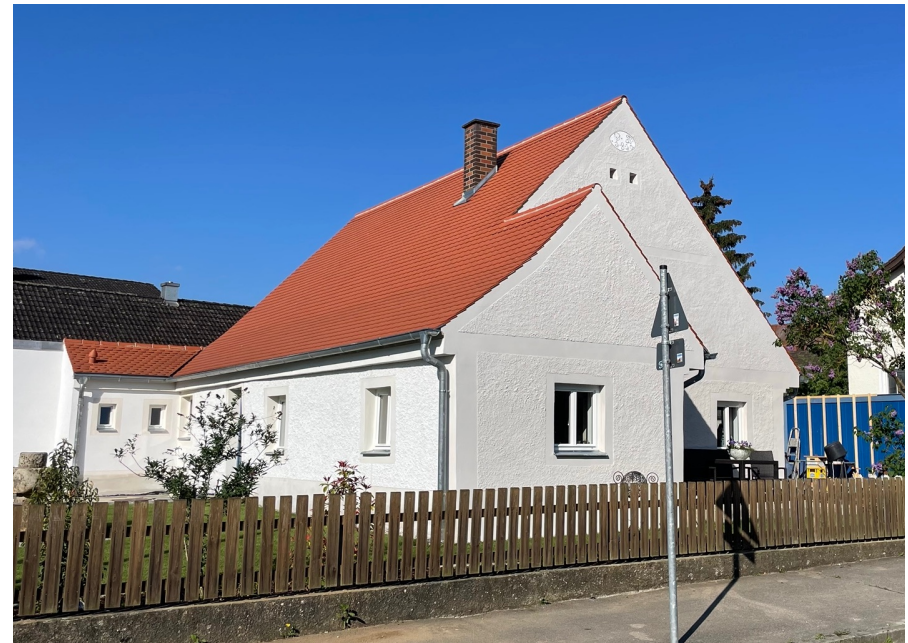
Saniert im Jahr 2024
