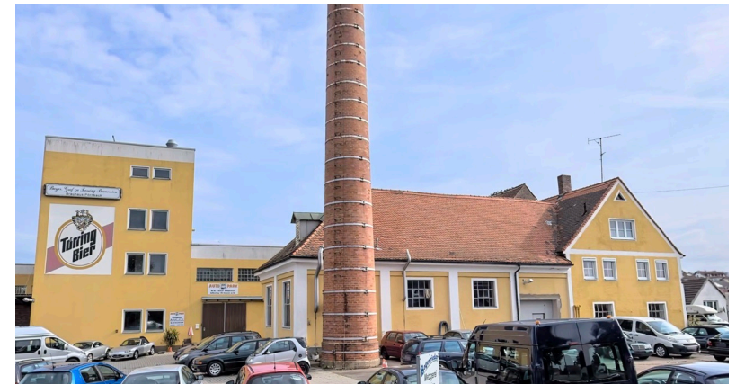
Ehem. Brauereiareal (Blick von der B13 Münchner Straße)
